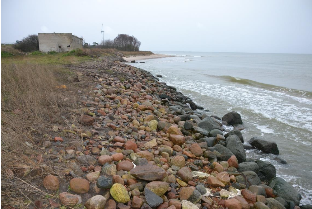
6.attēls. Mākslīgo krastu iecirknis ar laukakmeņu rip-rap un gabionu preterozijas būvēm pie Liepājas NAI. (Autors: J.Lapinskis)
